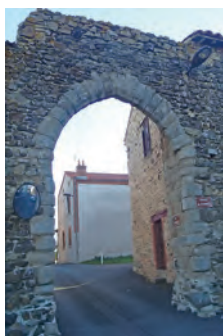
Photo : MAIRIE - Porche de Rilhac
