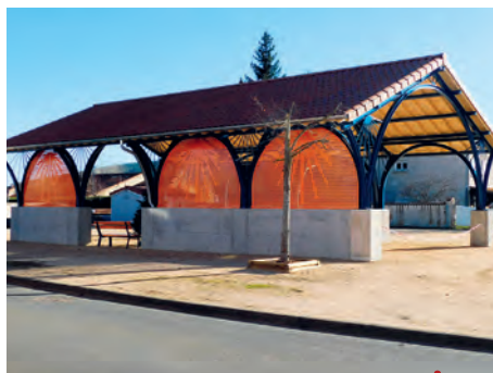
Halle couverte - Photo : MAIRIE
